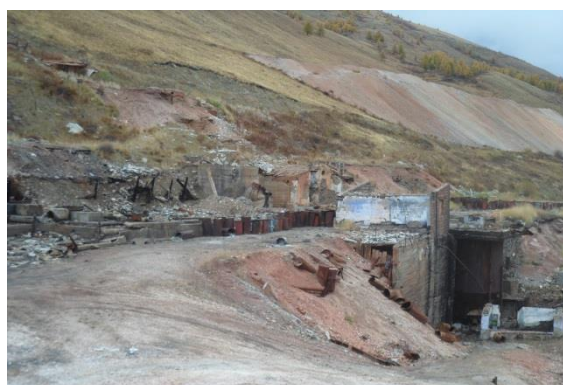
Фото 11 Остатки металлзавода АГМП
