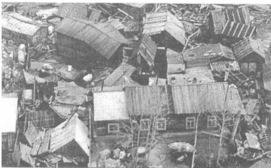
Рис. 1.7.1. Характер и степень разрушения деревянных зданий и техники в г. Ленске после заторного наводнения в мае 2001 г.
